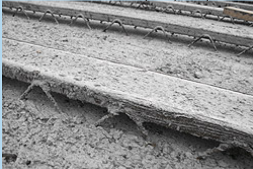
1- Renforcement en béton coulé en usine. 2- Armatures de liaison. 3- Prédalle.
