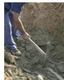
↑ Les SSP sont des bétons à durcissement «limité». Leur résistance à la compression à 28 jours se situe habituellement entre 0.8 et 1.2 N/mm<sup>2</sup> [MPa] et les prédestinent ainsi à la possibilité d'une réexcavation manuelle. Si nécessaire, le SSP peut être fourni avec une résistance à la compression de 2 N/mm<sup>2</sup>, voire supérieur, peut être spécifié à la commande, permettant, dans ce cas encore, une excavation mécanique confortable.
